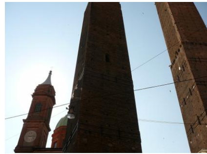
斜塔ですが写真では解りにくい (鋼鉄のワイヤで補強)
